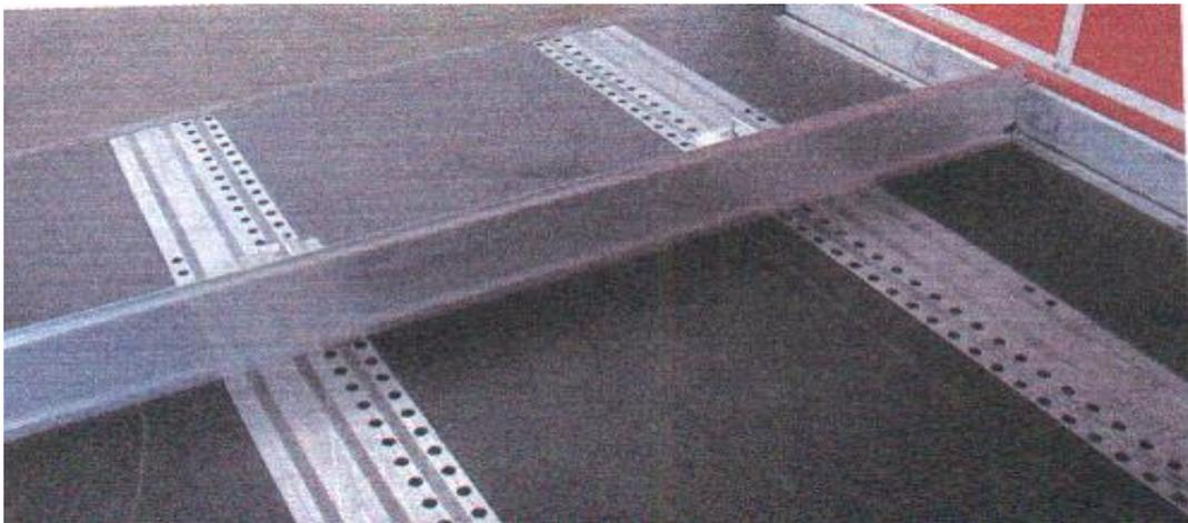
Abb.6: Anordnung Lochschiene und Sperrbalken
